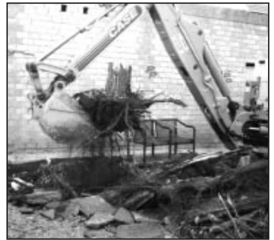
Retroexcavadora en pleno arranque de olmos.
